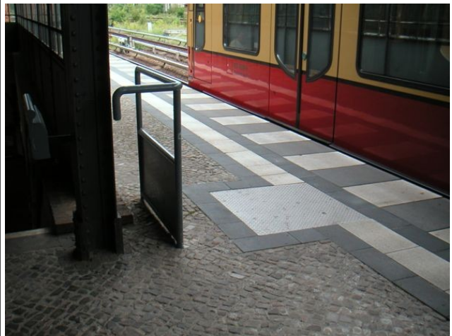
Bild 2: Hell-Dunkel-Wechselmarkierung der Bahnsteigkanten bei anderen S-Bahnhöfen, hier Bahnhof Grunewald
