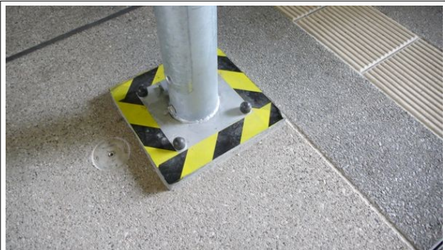
Bild 22: Man hat es wohl gemerkt, dass das nicht gut ist: hier im Bereich der Treppenaufgänge erhielten die Füße der Masten die schwarz-gelbe Schrägstreifen-Schutzmarkierung nach der Arbeitsstätten-Verordnung!
