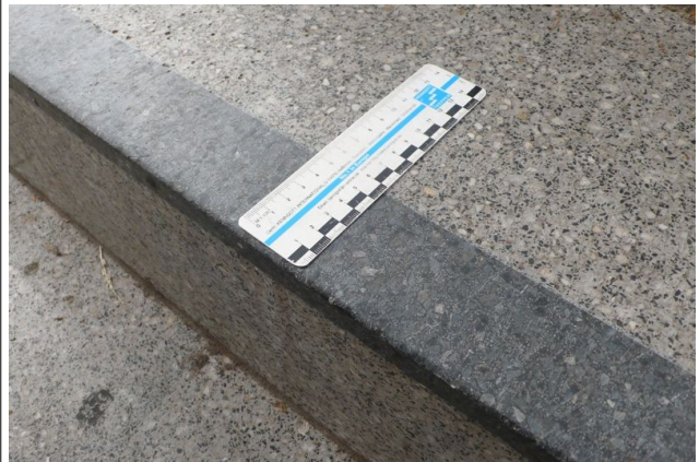
Bild 16: Korrekte Markierung der Stufenvorderkanten bei der S-Bahn Berlin z.B. im Bahnhof Charlottenburg der Stadtbahnstrecke, Aufgang West zum Bahnsteig Richtung Zoologischer Garten - so hätten Sehbehinderte es gern überall. Es ist mit Abstand die sicherste Markierung, wenn man eine Markierung nach Arbeitsstättenverordnung (gelb-schwarze Schrägstreifen) nicht in Betracht zieht. Das Paradoxon: die DB markiert alle Stufen mit gelb-schwarzen Schrägstreifen, wenn es um ihr eigenes Personal und die nur von diesen zu nutzenden Bauteile geht – den Kunden der Bahn wird aber diese auffällige und sicherste Markierung verweigert!
